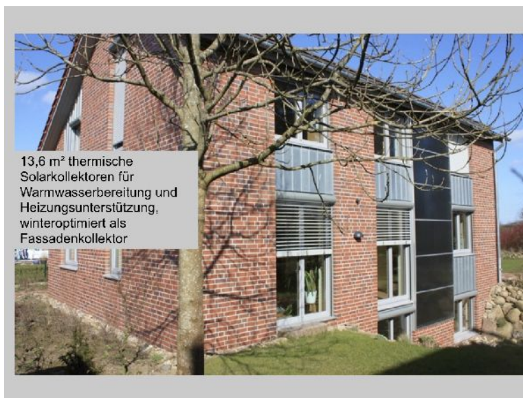
Abbildung 7: Ansicht des fertigen Passivhauses mit thermischen Kollektor als Wandelement
